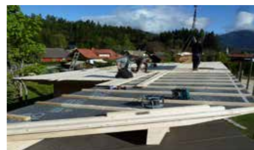
Das Kalddach ist bald fertig
