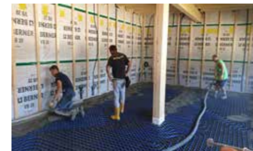
Profis beim Verlegen des Estrichs
