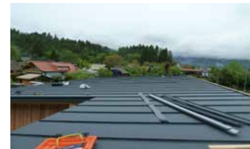
Es wurde mit Alu-Blech eingedeckt
