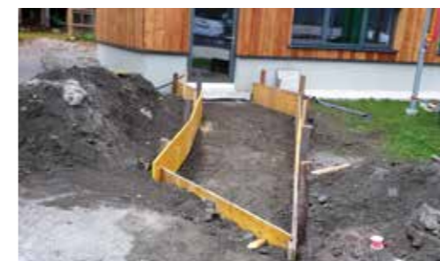
Aushub u. Schalung der Eingangsrampe
