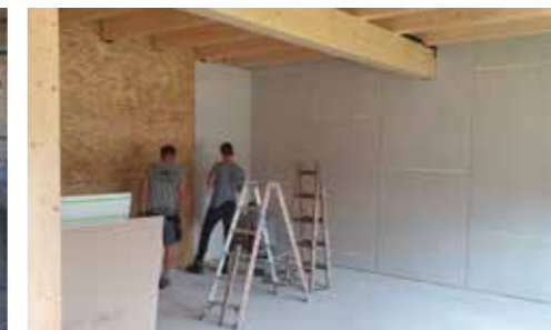
Noch einmal OSB-Platten und Rigips
