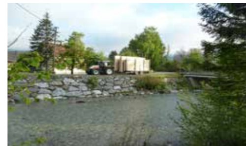
Beim Antransport der Holzkonstruktion
