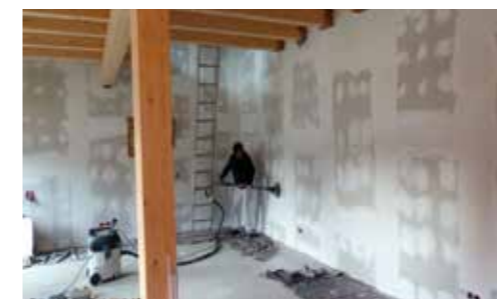
Schleifen der Wände erfordert Geduld
