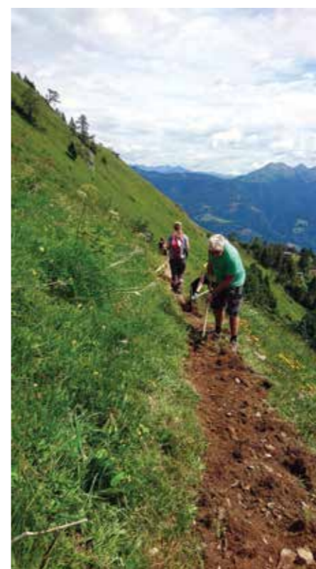
Foto: Beim Abgraben des Wanderweges
