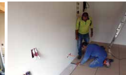
Bodenfliesen werden verlegt
