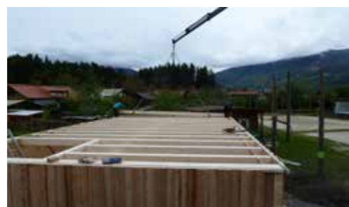
Die Deckenträme werden gesetzt
