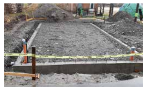
Das Streifenfundament
