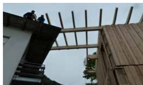
Das Dach zum Altbestand wird montiert
