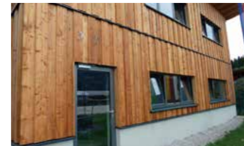
Einbau der Fenster ist gelungen
