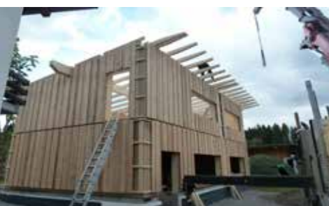
Die Sparren werde aufgesetzt
