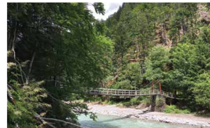
Foto: Die historische Hängebrücke „Aigner Steg“
