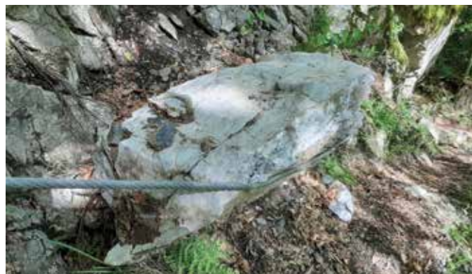
Foto: Felsbrocken hatten das Seilgeländer beschädigt
