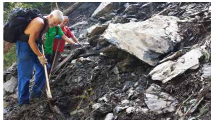
Foto: Ein neuer Steig musste zwischen Felsbrocken gegraben werden
