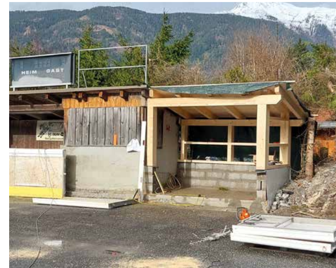
Foto: Auch der Bau einer zusätzlichen Hütte bei der Zeitnehmung war notwendig geworden
