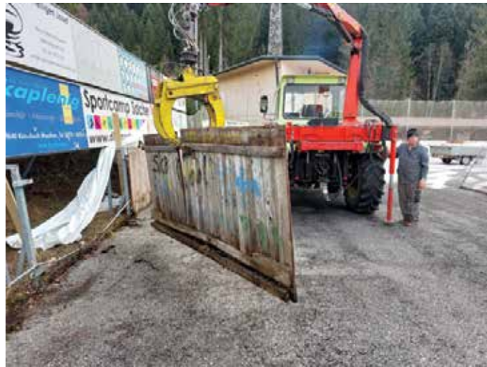
Foto: Mit schwerem Gerät wurden die alten Planken Stück für Stück abgetragen und anschließend zu Brennholz verarbeitet
