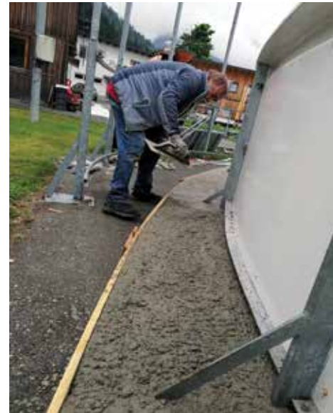
Foto: Exakt 18,5 Kubikmeter Beton wurden ringsum im Fundament verarbeitet
