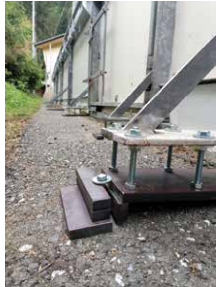
Foto: Jeder der 80 Steher wurde mittels Eisenplatten und Stellschrauben justiert
