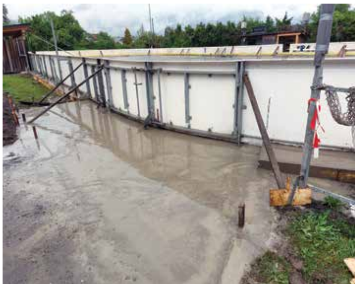
Foto: Nun waren die aus der Eishalle Pontebba stammenden Bandenteile fixiert und konnten weiterbearbeitet werden
