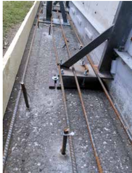
Foto: Mehr als 180 Laufmeter des Bandensockels wurden armiert und eingeschalt
