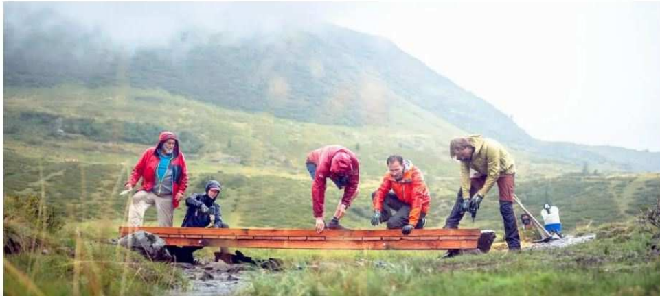
Sepp Lederer (links) mit einer Gruppe beim Errichten einer Brücke
