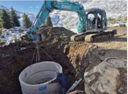
Foto: Einbau eines weiteren Schachtes
