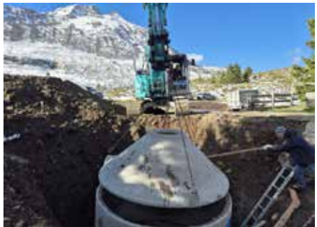
Foto: Der Konus wird aufgesetzt
