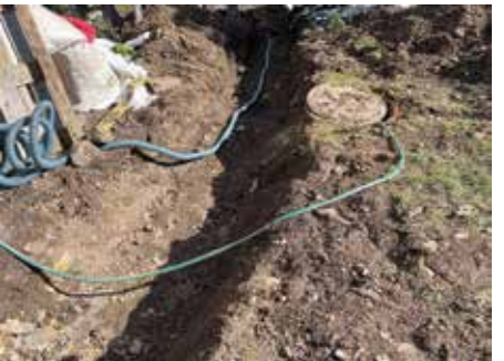
Foto: Mehr als 30 Meter Graben für Leitungen
