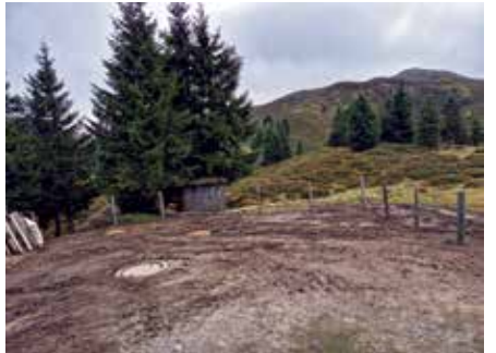
Foto: Die abschließende Planie
