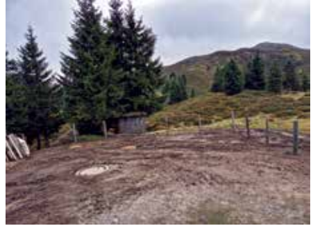
Foto: Die abschließende Planie
