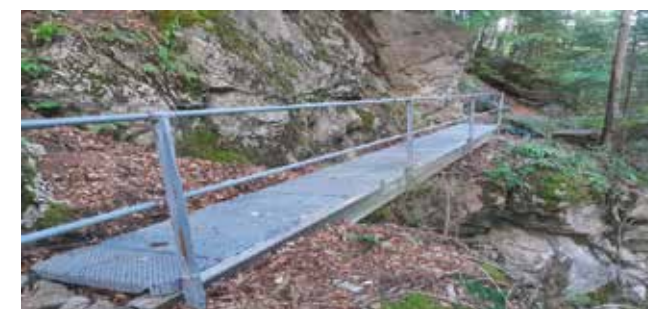
Foto: Die Brücke besteht nun aus unverwüstlichen verzinkten Teilen
