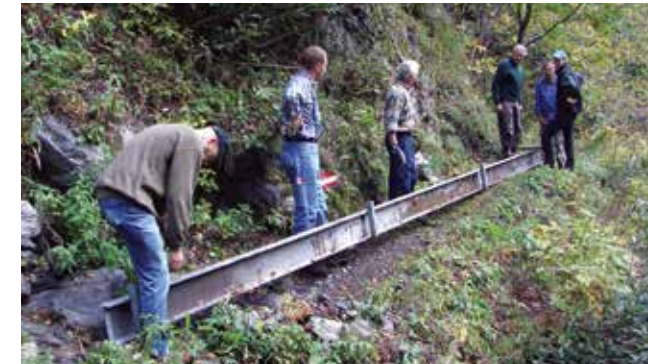
Foto: Die elf Meter langen I-Träger wurden 2006 vom Bautrup mühsam zur Baustelle geschleppt und vor Ort zusammengebaut
