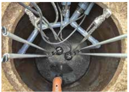
Foto: Zwei Pumpen im Pumpschacht
