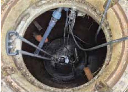
Foto: Eine Pumpe im Nachklärbecken
