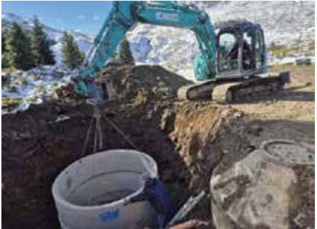
Foto: Einbau eines weiteren Schachtes
