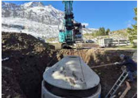
Foto: Der Konus wird aufgesetzt
